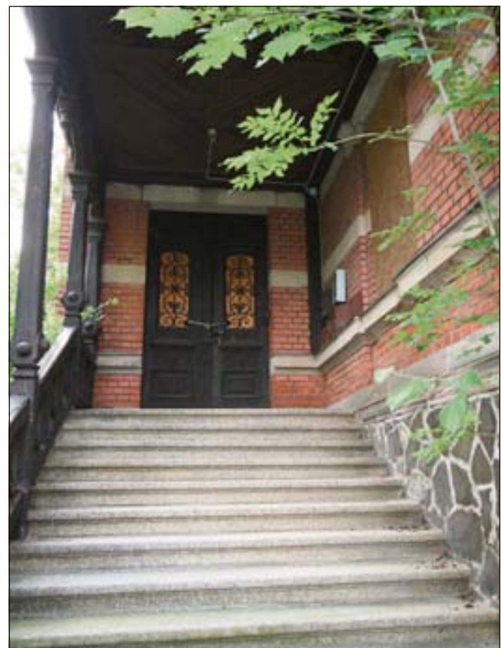
Ein herrschaftlicher Treppenaufgang führt zu der alten Villa, hinter deren Mauern sich wertvoller Stuck und Malereien befinden.
